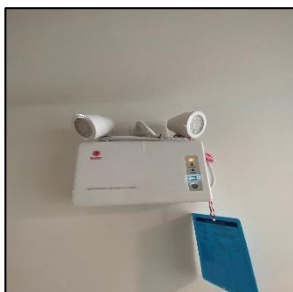
ภาพที่ 2.1-25 ระบบไฟฟ้าสำรอง
