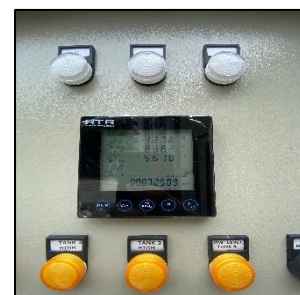
ภาพที่ 2.1-15 มิเตอร์แยกระบบบำบัด
